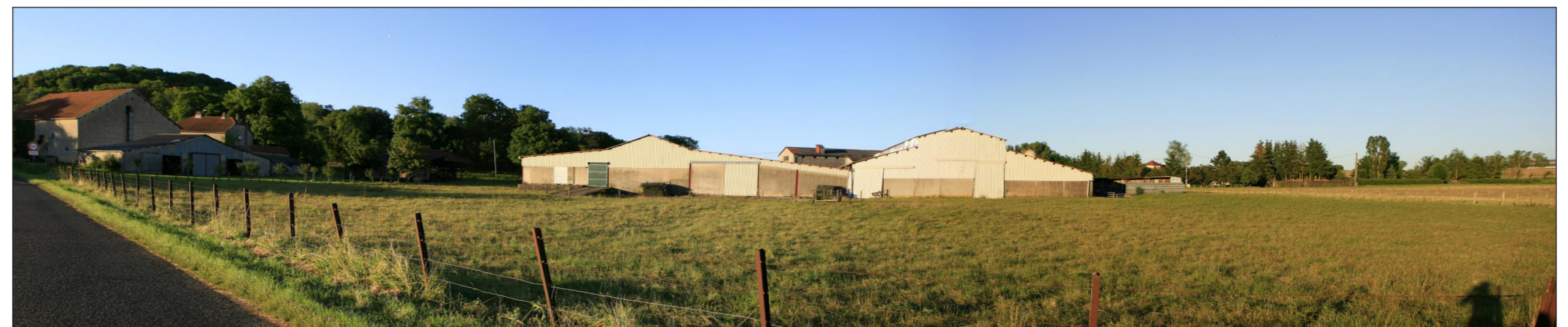
Vue du site avant projet
